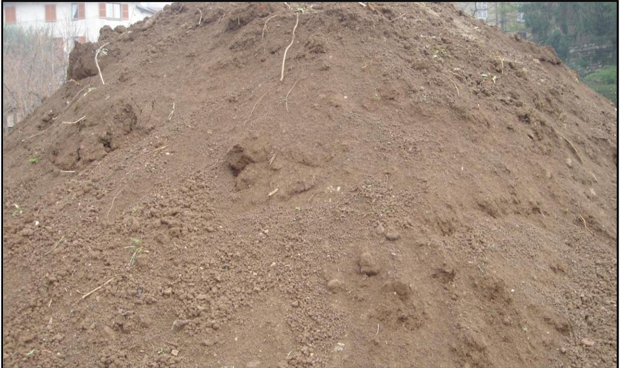
*foto 40 – depositi colluviali accumulati durante le fasi di sbancamento*
