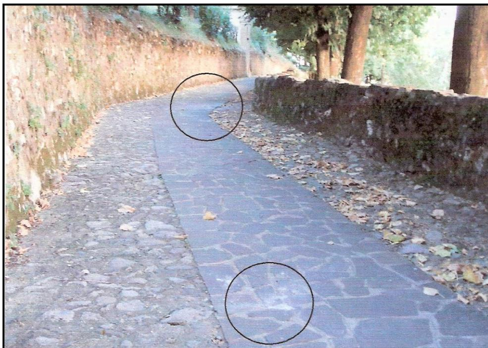
*Foto 8 – Punti di impatto masso caduto lungo il Viale delle Cappelle*
